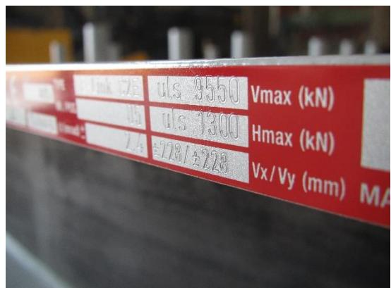
La faccia superiore dell'appoggio fornisce informazioni sul tipo dell'appoggio, la direzione dell'asse del ponte, la preregolazione (se presente), la posizione.
