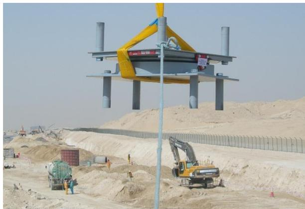
Tutti gli appoggi sono dotati di dispositivi robusti per il trasporto, per assicurare che i componenti restino nella corretta posizione relativa prima e durante l'installazione. Questi dispositivi di fissaggio temporaneo sono normalmente rifiniti con vernice color rosso e devono essere rimossi al termine dell'installazione.
