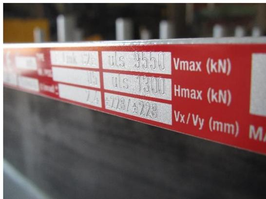
La superficie superiore dell'appoggio fornisce informazioni sul tipo di appoggio, la direzione dell'asse del ponte, la prerogolazione (se esiste), la posizione all'interno della struttura.
